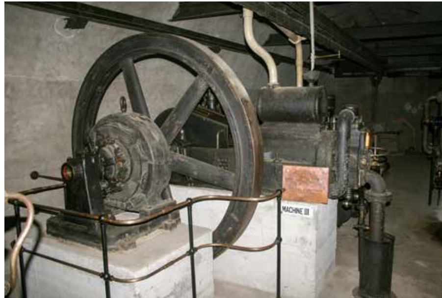
Un des moteurs originaux qui sera installé dans l'usine du fort - collection ADFM
