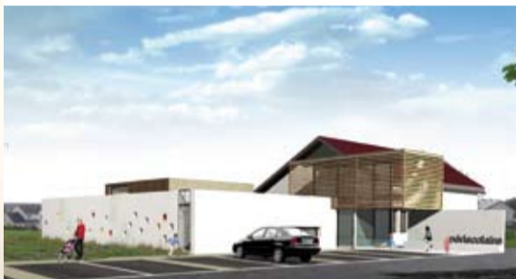
Extension du Périscolaire
